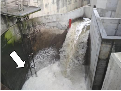
Foto 1: Vista xeral do efluente tratado entrando na cámara de carga do emisario. Sinálase a comporta do emisario
