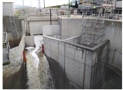
Foto 2: Detalle da estrutura que se construíu para a instalación da turbina
